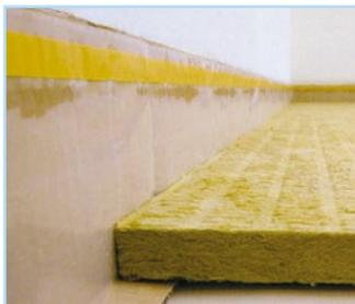
Mineralische Trittschalldämmung mit Randdämmstreifen
