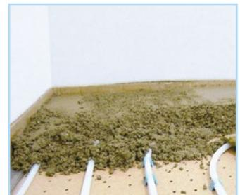
Sauerstoffdichtes Rohrsystem von hp praski mit Heizestrich
