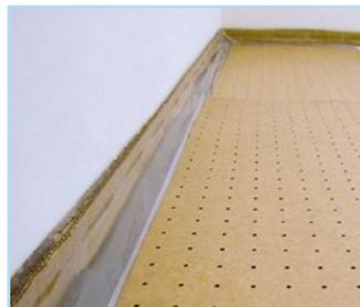
biofaser Biofaser-Lochplatte® mit PE-Folie Feuchtigkeitsschutz
