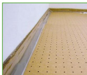
biofaser-Lochplatte® auf Estrichfolie und Trittschalldämmung
