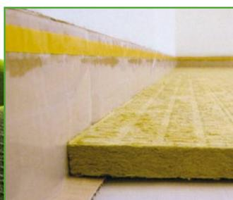
Mineralische Trittschalldämmung mit Öko-Randdämmstreifen
