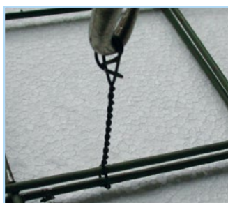
Verbinden der Gittermatten
