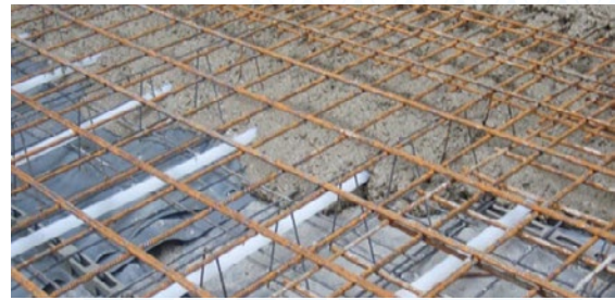
Beispiel: Rohrbefestigung auf der unteren Bewehrung
