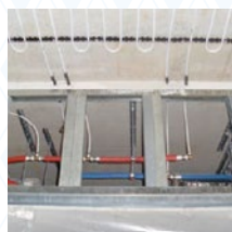
Schutzrohr 13/16 mm bei Wanddurchführung
