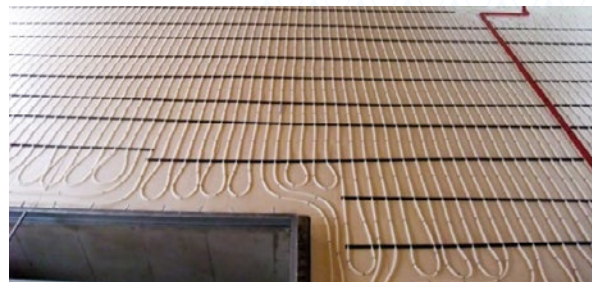
Beispiel: Rohrbefestigung auf der Perimeterdämmung
