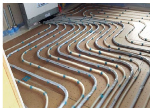
DLZ-Dämmung auf Biofaser-Lochplatte
