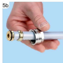
5b Aufstecken der Klemmringverschraubungsteile (Überwurf, Klemmring geschlitzt, Einstecktülle). Auf eine korrekte Einstecktiefe ist zu achten
