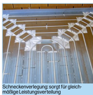
Hoher Blechanteil = Lastverteilend
