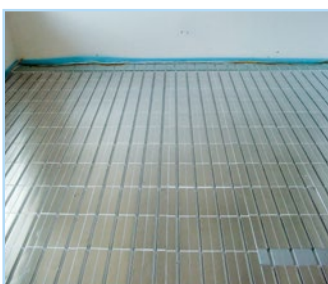
Vollflächiges Aluminiumleitblech
