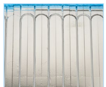
Verlegte Fläche mit Rohrleitungen
