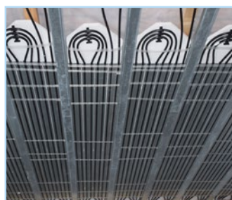
Montiertes System vor der Beplankung
