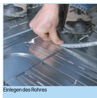
Schneckenverlegung: sorgt für gleichmäßige Leistungsverteilung
