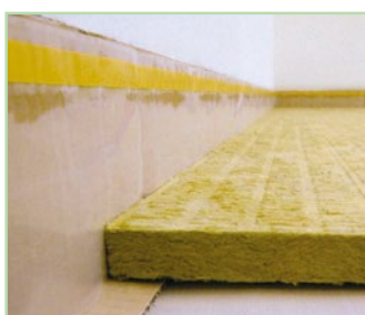
Mineralische Trittschalldämmung mit Öko-Randdämmstreifen*
