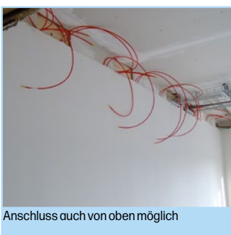
Verteiler zum Heizen und Kühlen
