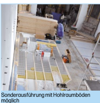
Vollflächiges Aluminiumleitblech
