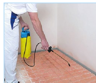
Grundierung der Oberfläche
