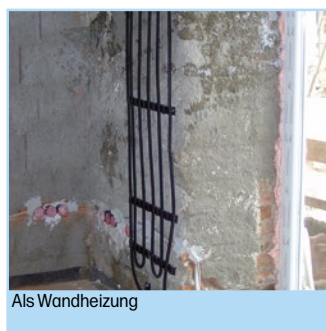
P70 Rohr 10 x 1,3 mit Schutzrohr
