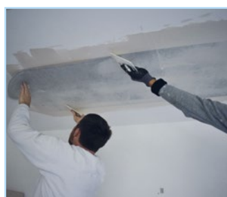
Einarbeiten der Carbon Fleece Heizfolie
