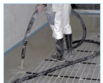
Einbringen des Nivellierestrich bzw. Ausgleichsmasse
