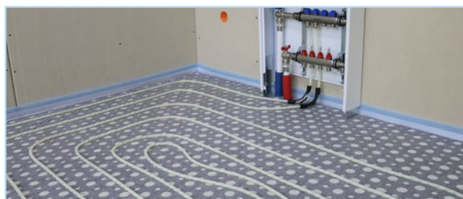
Rohr mit Klettbefestigung
