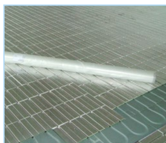
Dämmung ist bei der Montage bereits geschützt
