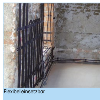
P70 Rohr 10 x 1,3 mit Schutzrohr
