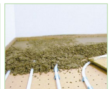
Einbringen des Estriches
