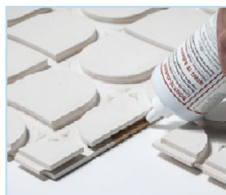
Verkleben der Elemente
