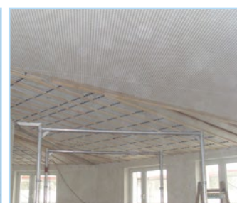
Sandwichdecke mit fertiger Decke im Vordergrund
