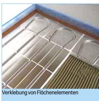
Rohrverlegung
