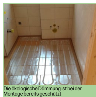
Vollflächiges Aluminiumleitblech
