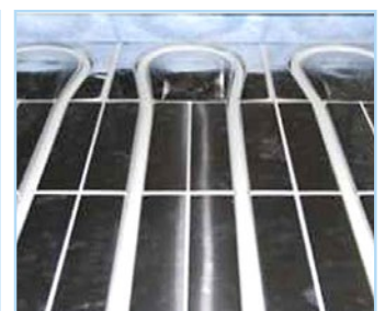
Fertig verlegtes Rohr
