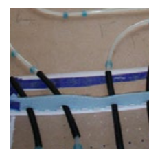
Schutzrohr bei Biofaser-Lochplatte mit Dehnfugenprofil mit Dehnfuge blau
