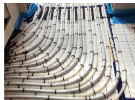
Biofaser-DLZ-Dämmung auf Flies-Tacklersystem
