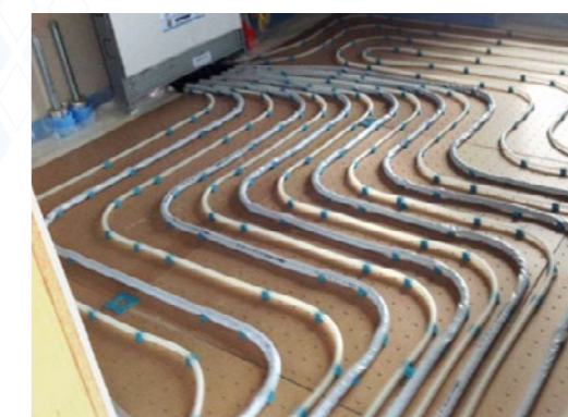
Biofaser-DLZ-Dämmung auf Biofaser-Lochplatte
