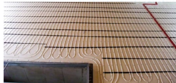
Beispiel: Rohrbefestigung auf der Perimeterdämmung
