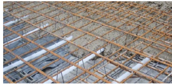
Beispiel: Rohrbefestigung auf der unteren Bewehrung
