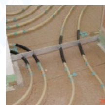
Schutzrohr bei Biofaser-Lochplatte
