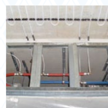
Schutzrohr 13/16 mm bei Wanddurchführung
