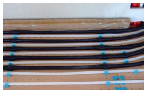
Diese Schutzrohre sind an der Schlitzung überlappend. Dies verhindert das Eindringen von Ausgleichsmasse bzw. Fließestrich in den Hohlraum zwischen Rohr und Schutzrohr. Ein einzigartiges Merkmal in diesem Bereich.
